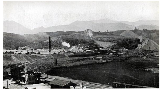
昭和20年(1945)代の峰地炭鉱 峰地1坑全景
