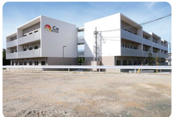
建替後の朝日ヶ丘団地
