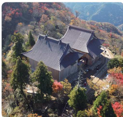
上宮修復等整備
