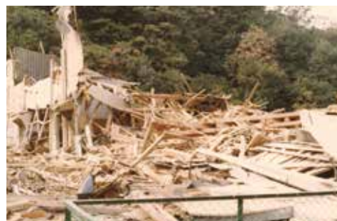
旧校舎解体作業 昭和54年10月
