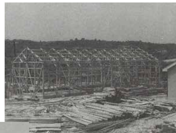
旧校舎建築 昭和34年
