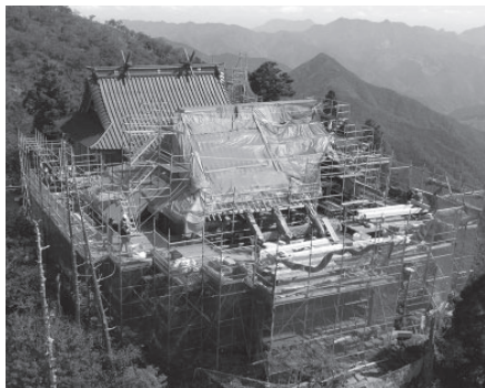
↑ 工事中の英彦山神宮上宮(令和6年10月撮影)
