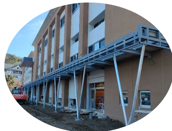
体育館棟の底(ひさし)
