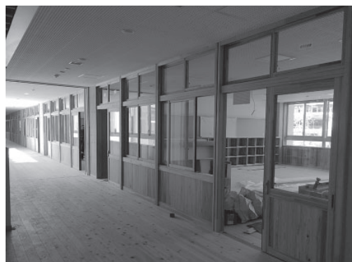
廊下の床や壁、教室のドアまで木材を使用し、学校中が木の香りに包まれています
