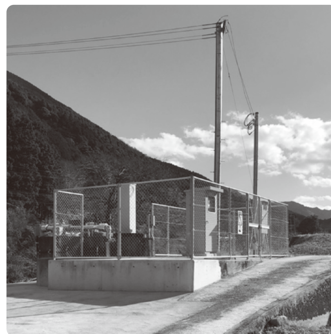
災害復旧された簡易水道水源地(落合)
