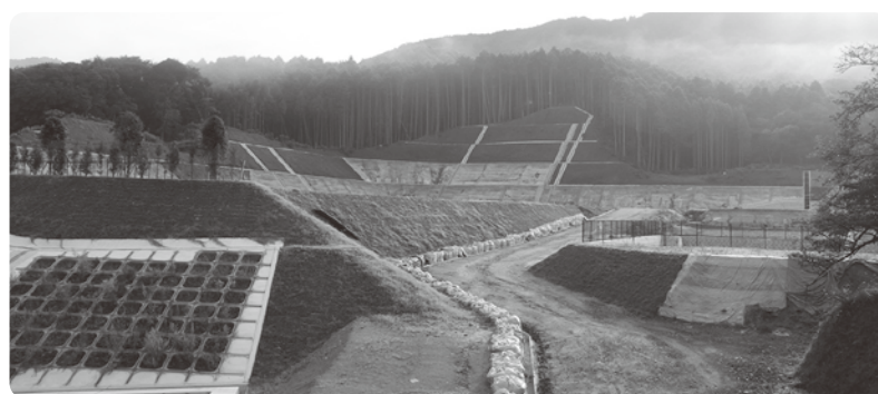
整備が進む処理場(大任町)
