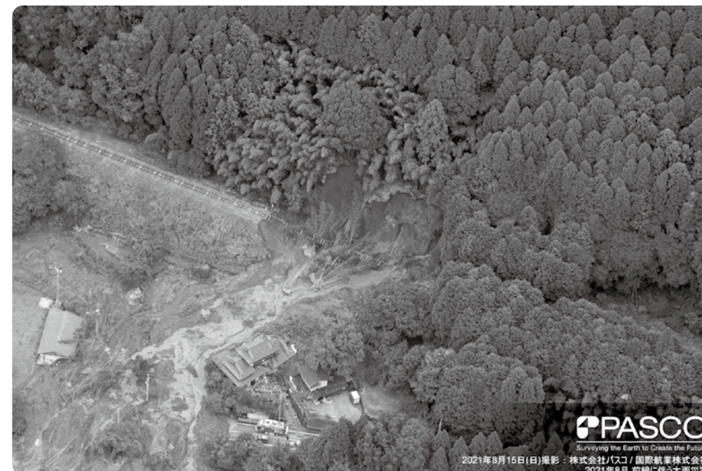
大きく崩壊し、田に浮いた線路
