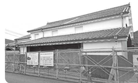
間もなく完成の中島家
