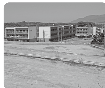
木造住宅を建設予定
