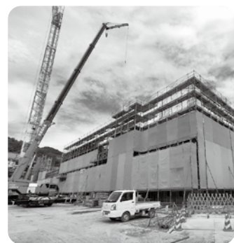
建設が進む新校舎
