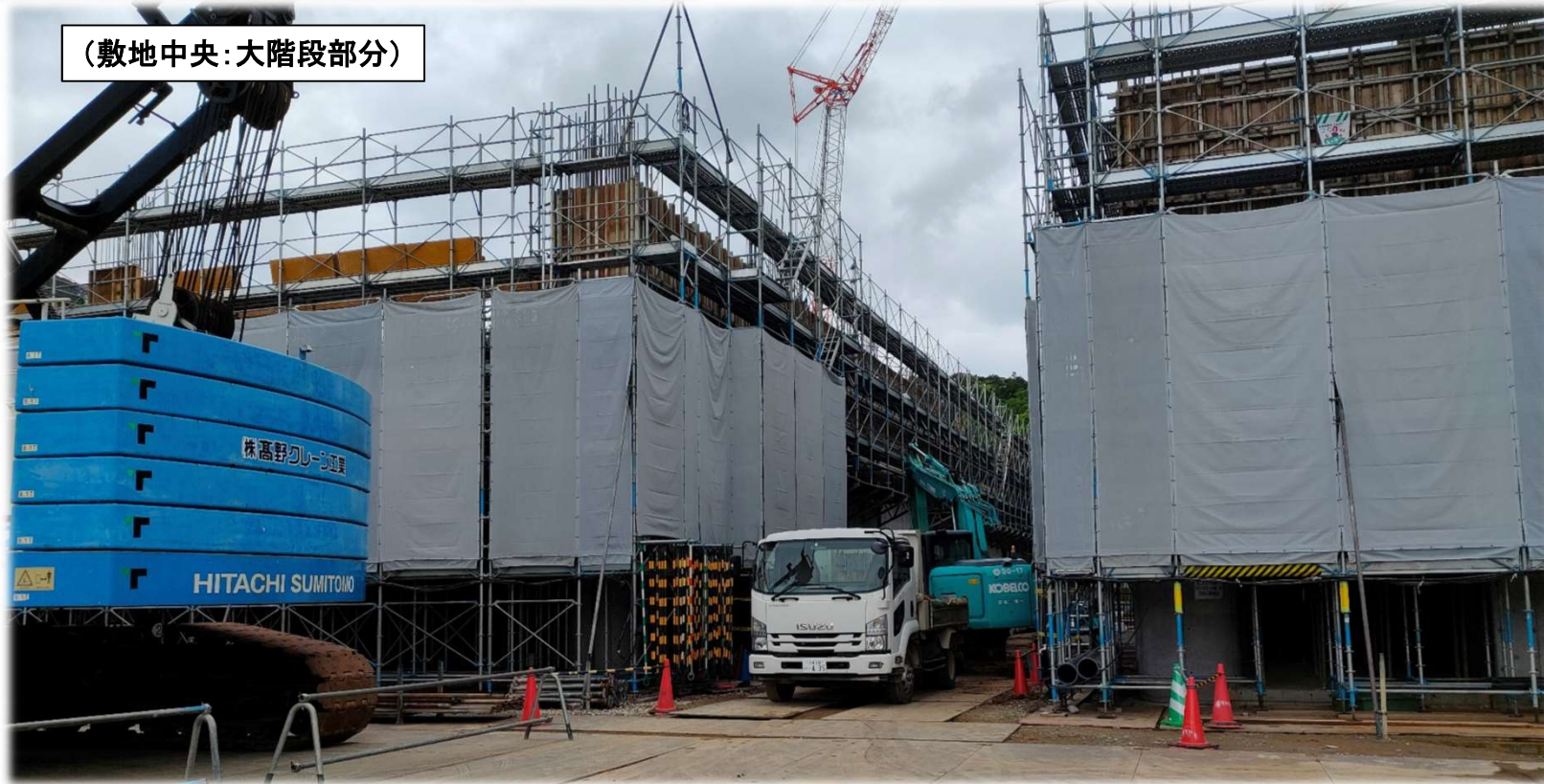
◀ 敷地中央の大階段部分の作業風景
