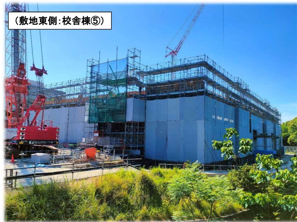
◀ 敷地東側の河川沿いからの作業風景
