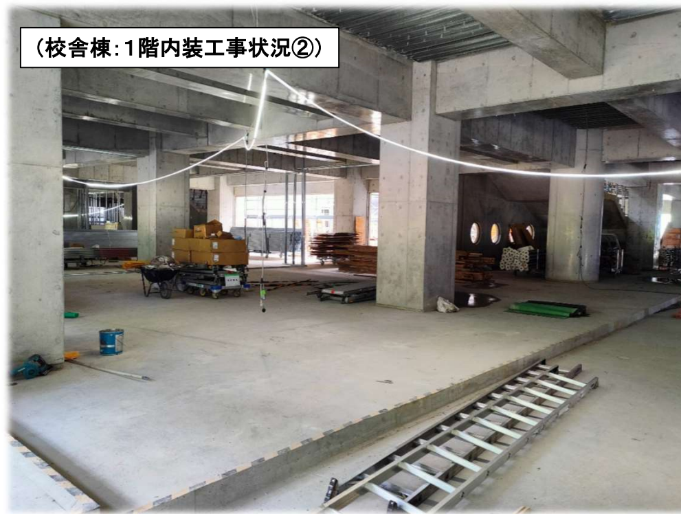
◀ 校舎棟内部の作業状況
