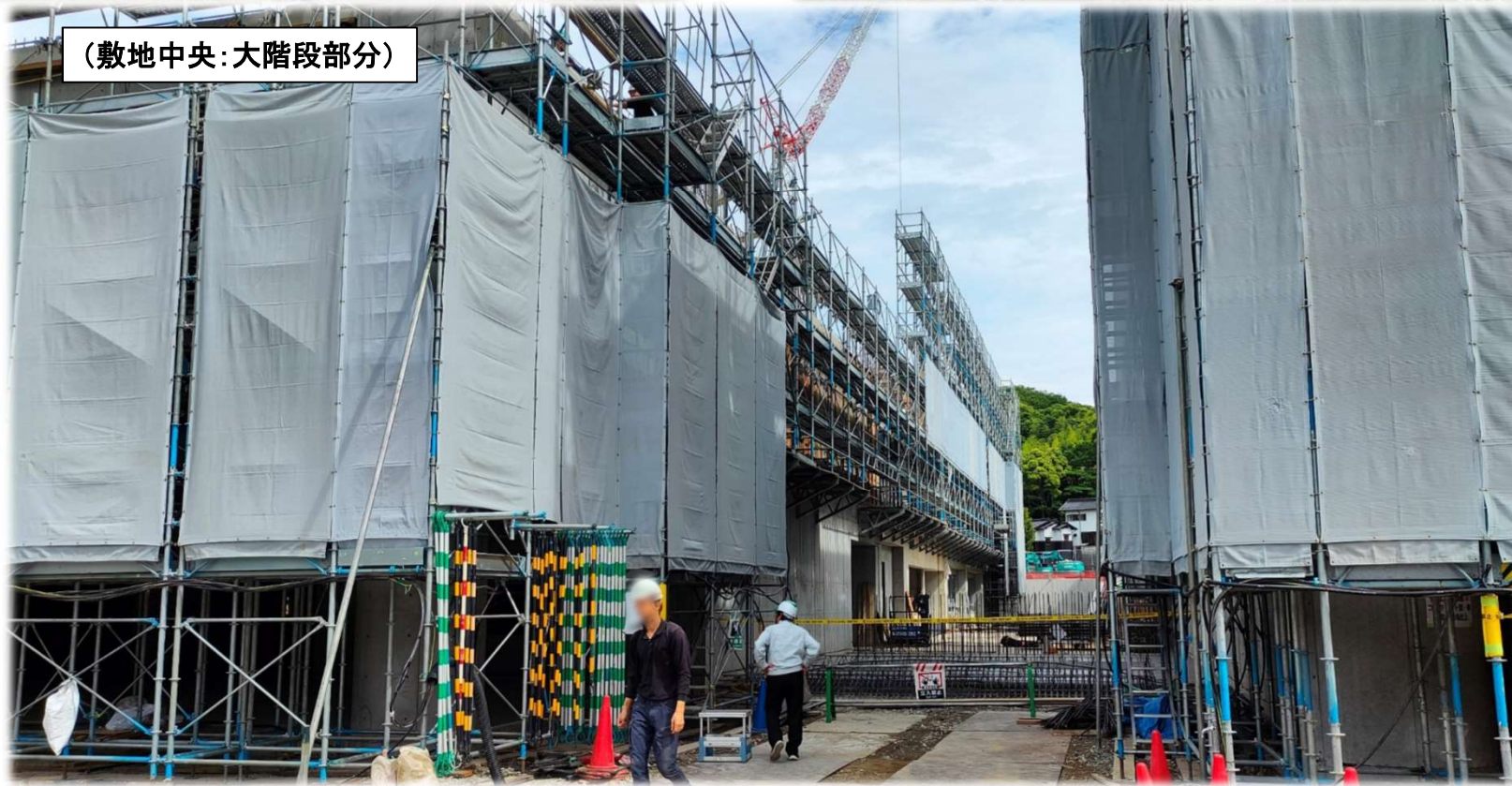
◀ 敷地中央の大階段部分の作業風景
