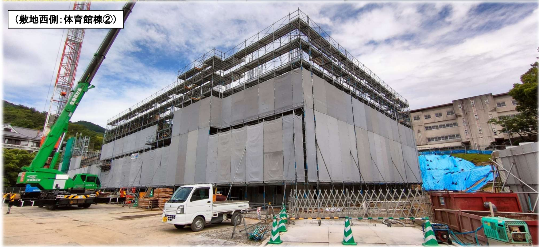
◀ 体育館棟正面の作業風景
