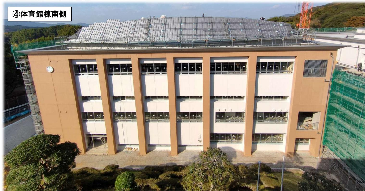
体育館棟南側は外装工事が完了したため、建物を囲っていた外部足場を撤去しました。これから徐々に足場が外れ建物の外観が見えるようになっていきます。
