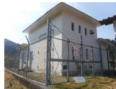
上中元寺簡易水道施設
