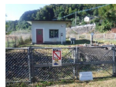
下中元寺浄水場
