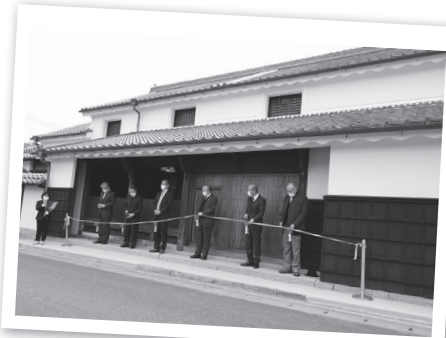
↑ 平成28年度から行ってきた保存修理工事が完成し、建築当時(江戸時代)の姿に戻りました
