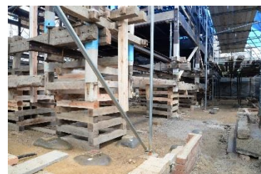
解体工事（揚屋）の様子
