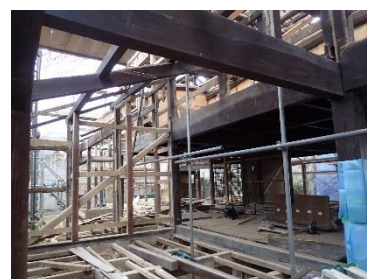
解体工事の様子
