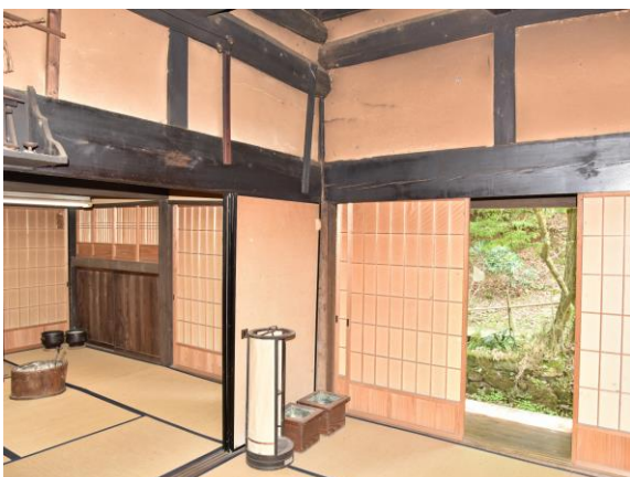
財蔵坊 補修工事前
