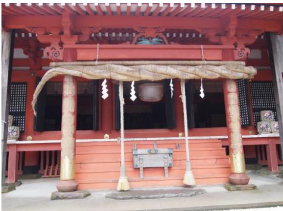
奉幣殿美装化事業 施工前
