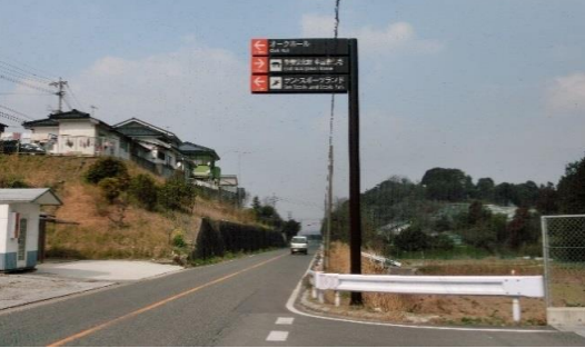
【大字添田分】 上:設置工事 下:設置後
