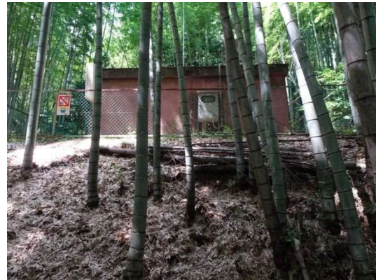
写真-3.5 落合低区配水池
