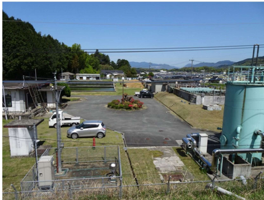
写真-3.2 添田町浄水場
