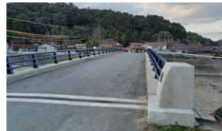
橋梁改築工事(本村橋)
