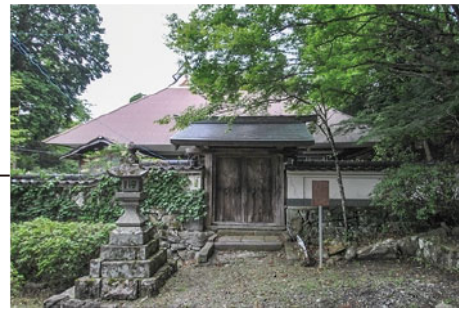
浄境坊 蕎麦屋やカフェなど 試験的な活用を所有者が検討中
