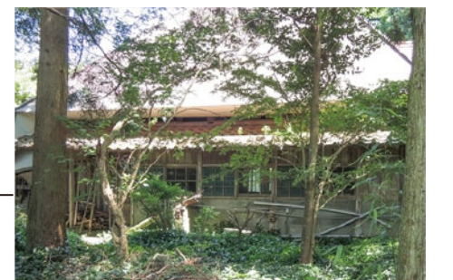
増了坊 雨漏り対策 要
