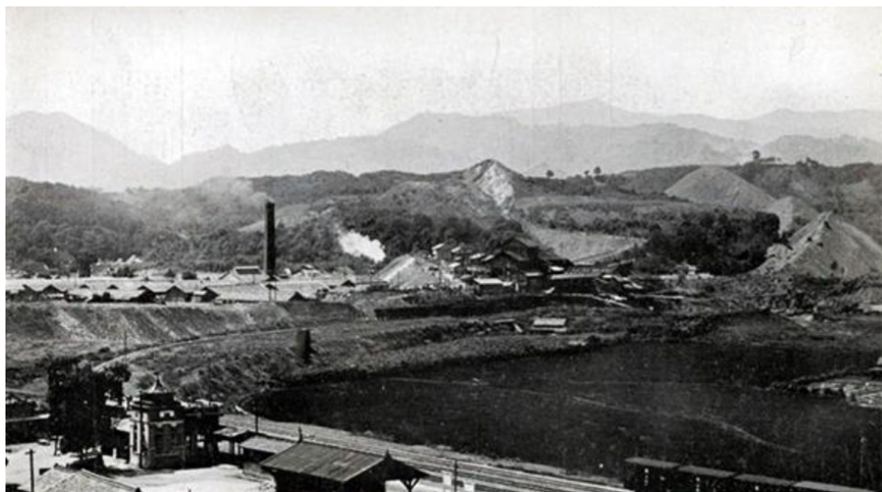
峰地炭鉱 峰地1坑全景
