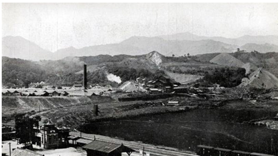
峰地炭鉱 峰地1坑全景
