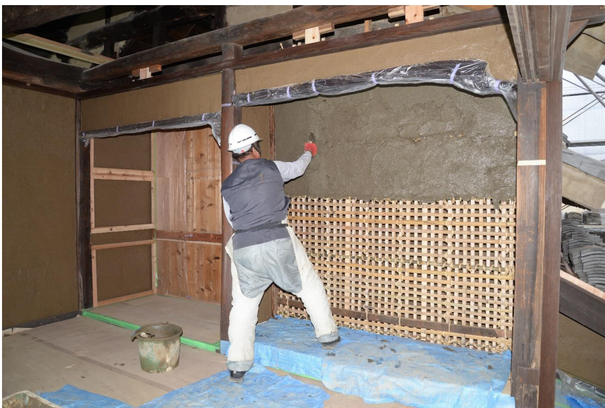
2階 座敷の土壁の塗り作業
