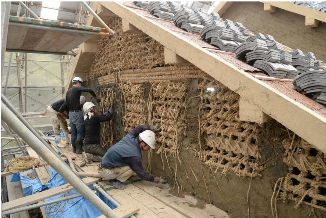
土壁の塗り作業
