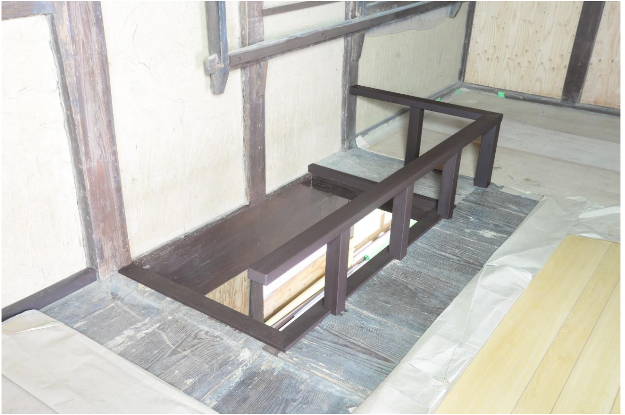
2階 手すりの設置
