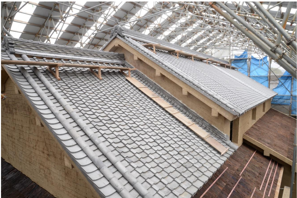
屋根瓦（取り替え後）
