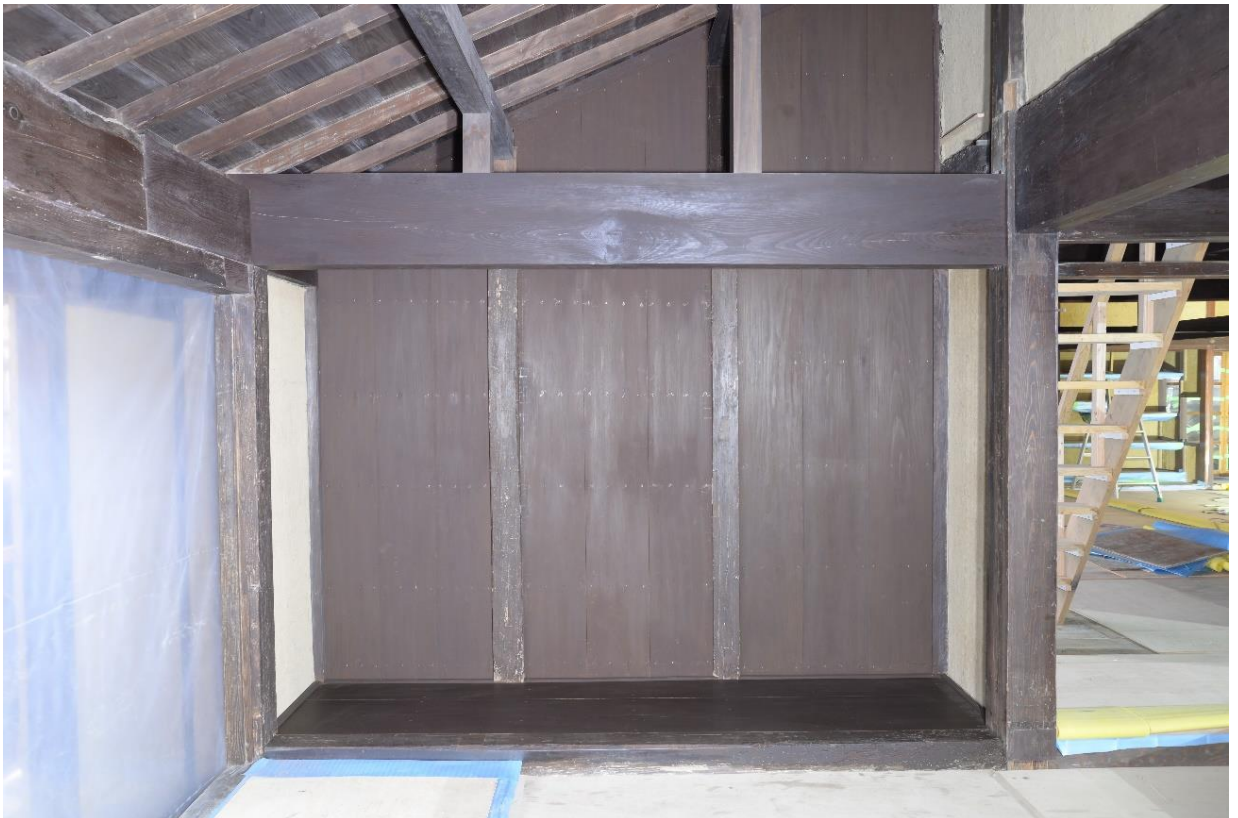
1階 「おみせ」部分の壁板の取り付け
