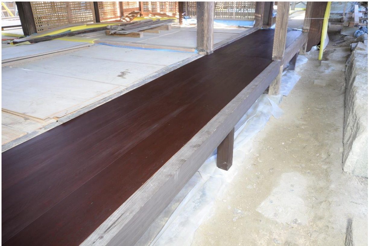
縁側の板を張り替え
