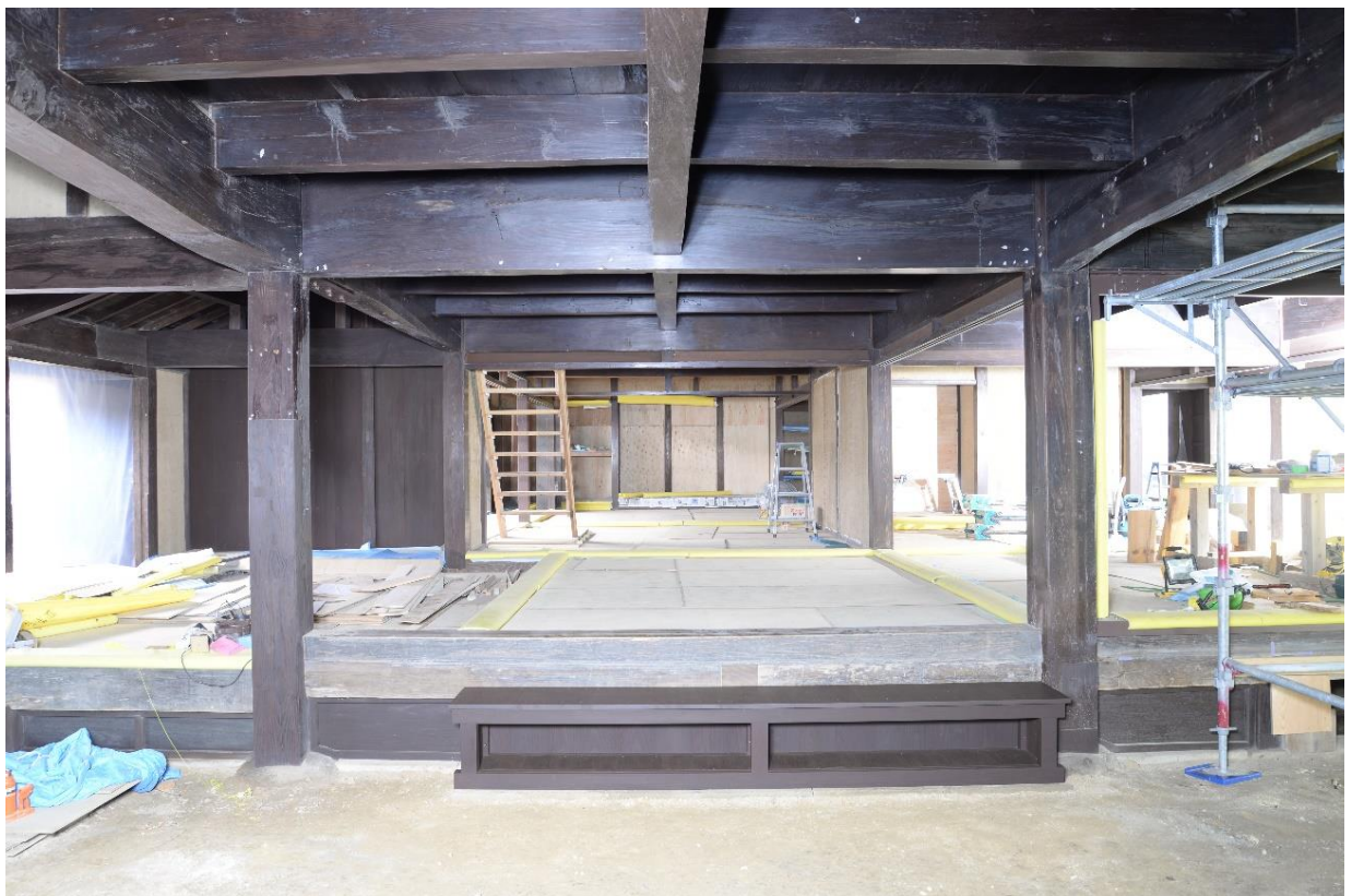
土間から居間へ踏み台の設置
