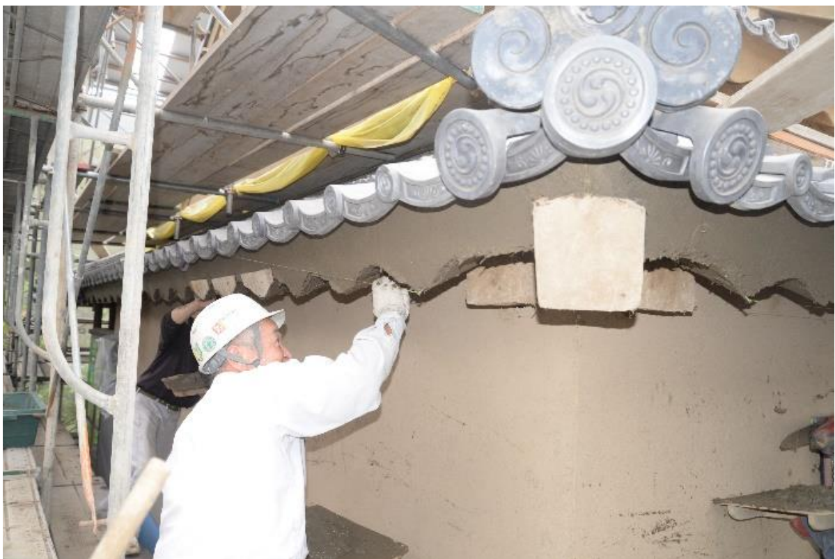
土壁の手直し
