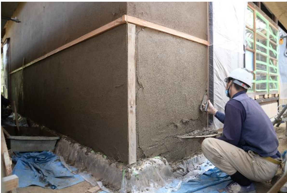
土壁の塗り作業
