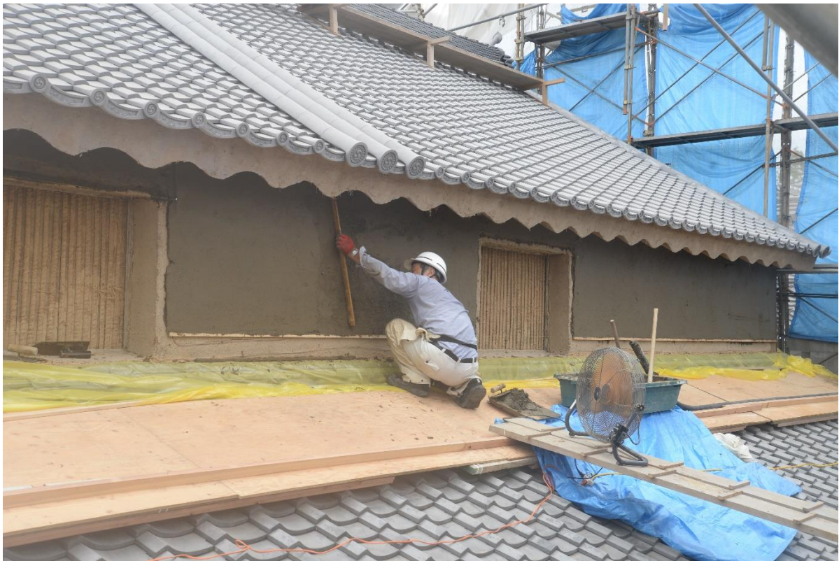
土壁の手直し
