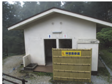
図表 136 トイレ (スロープカー神駅付近)
