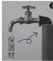
①屋外に露出している水道管に保温材を取り付ける
