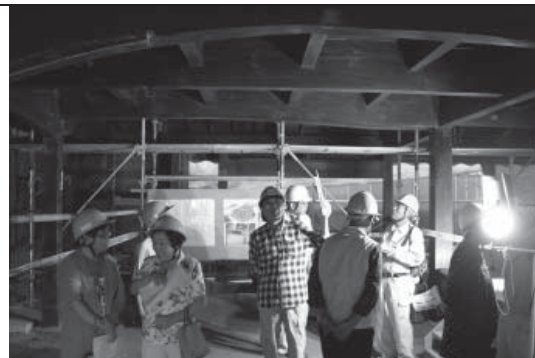
↑修復中の中島家内で工事関係者の説明を聞く見学者の皆さん
