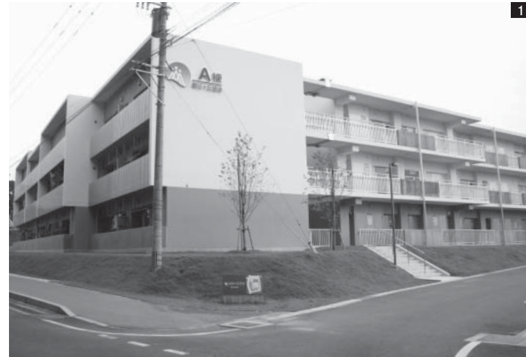
第1期工事のA棟とB棟が完成
