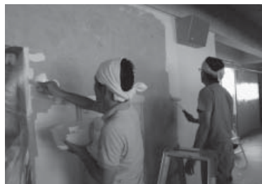
←校舎の内壁を塗るPTA役員
