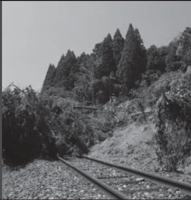
↑野田地区のクアハウスハビネス横の土砂崩れ 昨年の豪雨から不通の線路に押し寄せた倒木
