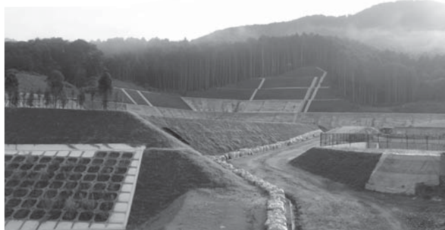
▲ 大任町に建設中のし尿処理施設（汚泥再生処理センター）
