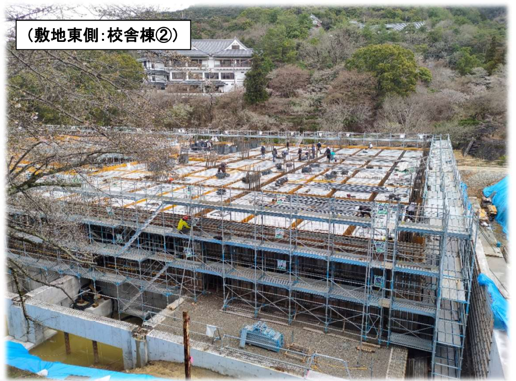
◀ 1階躯体コンクリート打設準備中
