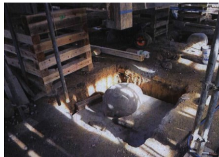
コンクリート 基礎補強と 礎石据付
