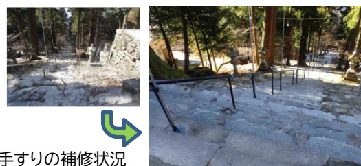
町道接道部の補修状況
