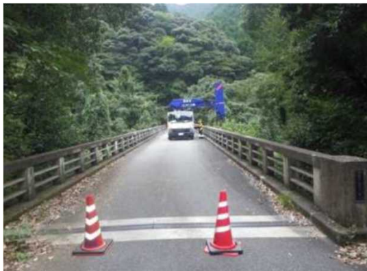
[ ゴンドラ車による点検状況：木浦橋 ]
