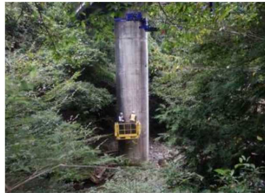
[ ゴンドラ車による点検状況：木浦橋 ]
