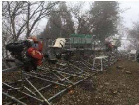
英彦山神宮上宮修復工事 中：運搬用モノレール
